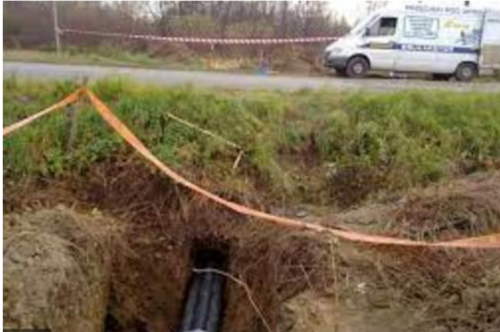
Rys. 31. Kanał kablowy umieszczony metodą przewiertu
