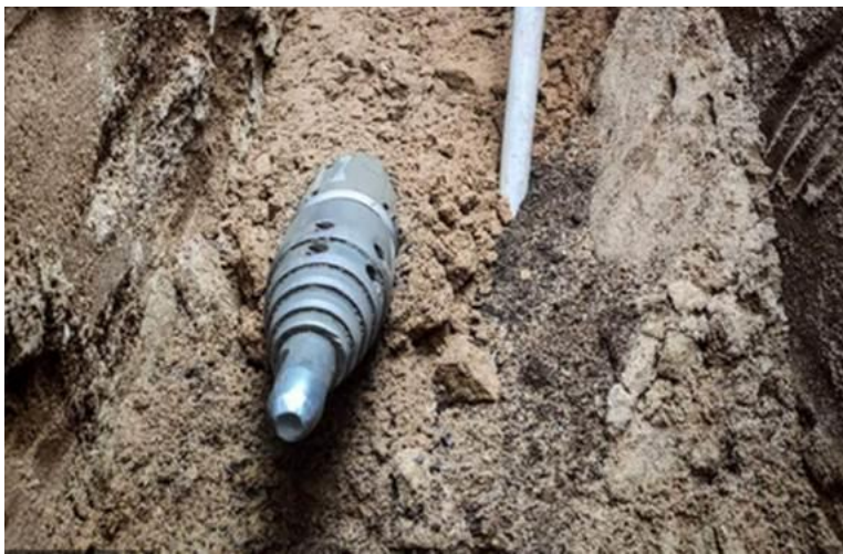
Rys. 27. Kret ciągnący rurę
