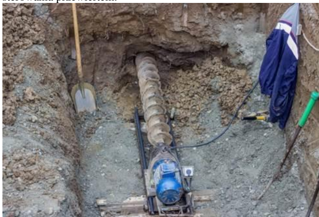
Rys. 30. Wykonywanie przewiertu
