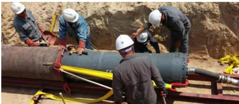
Rys. 28. Przecisk z ubijakiem umieszczonym za rurą stalową
