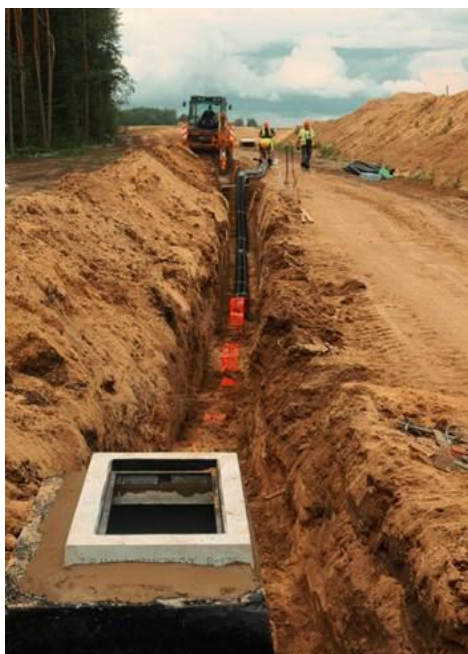
Rys. 34. Zamontowana studzienka kablowa
